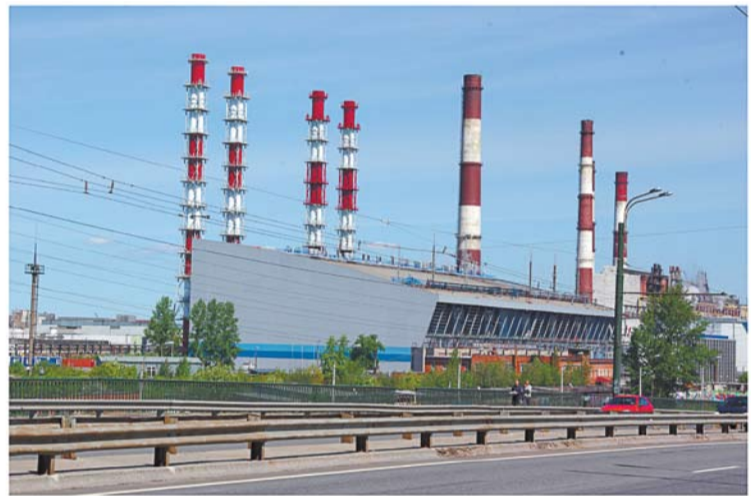
ООО «ОКЗ Русхолдинг». Реконструкция РВСП-20000 м³ №19 РП «Никольская»
