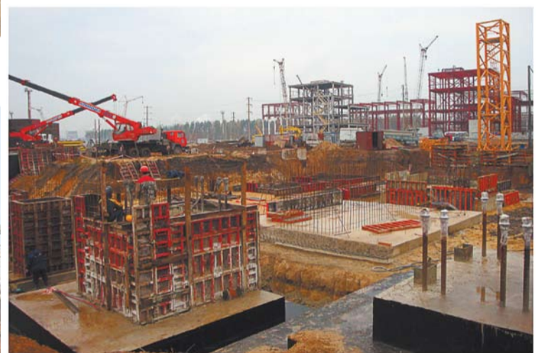
ЗАО «Екон-Строй». Возведение и монтаж трамплинов. Горнолыжный комплекс «Снежинка», г. Чайковский
